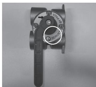
*By-Pass : poignée perpendiculaire à la vanne, l'eau non adoucie va directement dans la conduite et ne passe plus par l'adoucisseur.*
