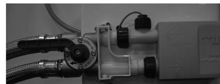
8. Ouvrir progressivement la vanne by-pass et vérifier l'étanchéité du montage.
